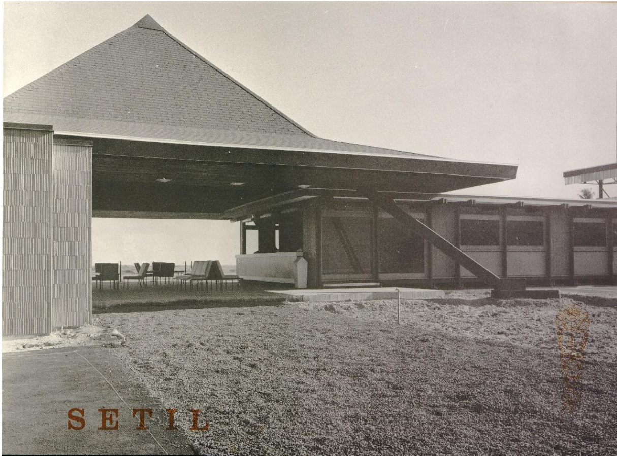
Aérogare d'aviation générale (1970-1971). Maître de l'ouvrage : SETIL. Petite aérogare et hangar destiné au trafic local. Capitaux mis en œuvre : 15 millions CFP (prêt CCCE). Entreprises : Jean Lot, Technique Service. Source : Brochure anniversaire SETIL 1961-196, collection particulière.
